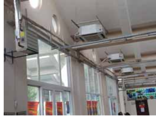
Sümerpark doğalgaz dönüşümü
