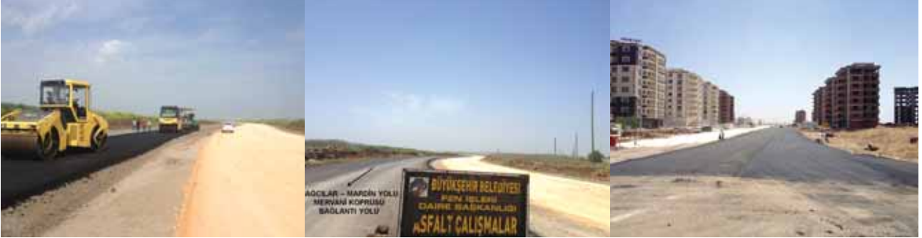
Bağcılar- Mardin Yolu- Bağivar Köprüsü bağlantı yolu
