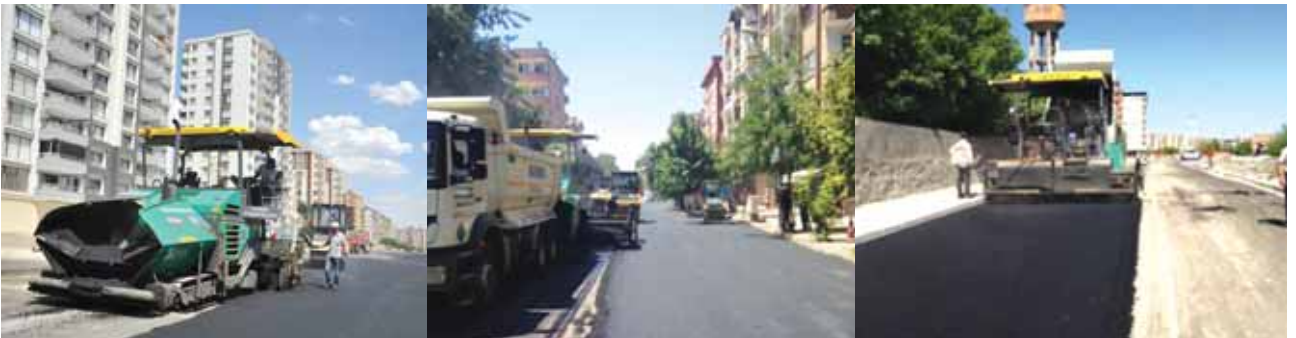
Asfalt ve yol çalışmaları
